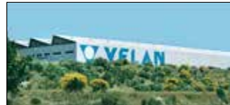
Lisbon, Portugal Velan Válvulas Industriais, Lda.
